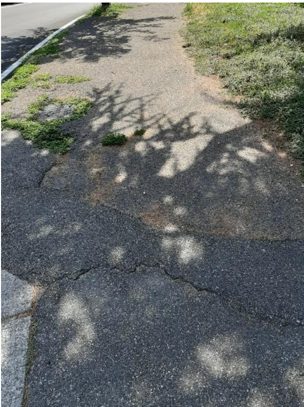
Marciapiede Via Manzoni - Foto 2
